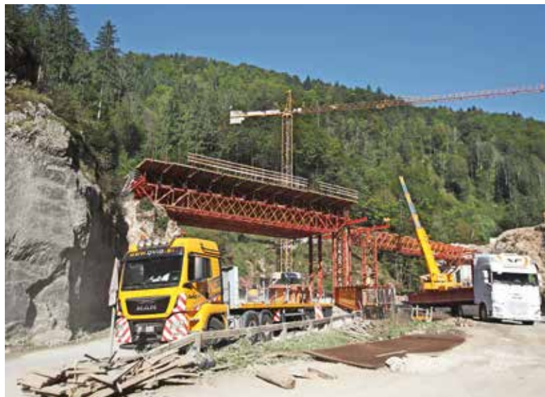
Urejanje območja zadrževalnika pod Sušo, kjer že izvajajo tudi opaž za viadukt za novo traso regionalne ceste / Foto: Gorazd Kavčič
